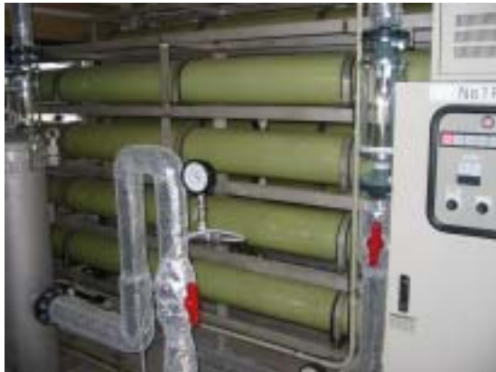
膜処理施設 地下水を処理している
