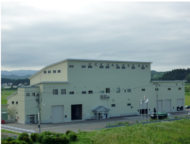
新庄汚泥燃料化設備プラント前景
