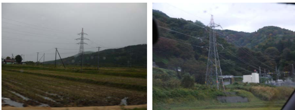
図表 5-85 農地内に建設された鉄塔（例）
