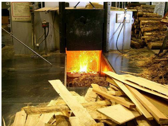
図表2-30 「秋川溪谷瀬音の湯」の薪ボイラー(温泉加温) 図表2-31 飯南町役場頓原庁舎(施設暖房)
